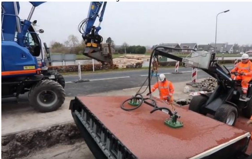
Рисунок 2. Замена поврежденного участка дорожного полотна
